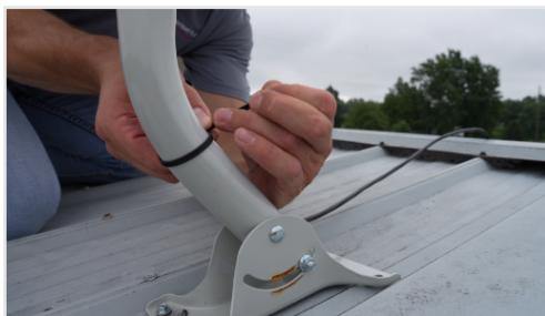
3) Fixez le câble Ethernet au mât d'antenne et à la structure à l'aide d'attaches autobloquantes. Ne tirez pas trop fort pour ne pas endommager le câble.
