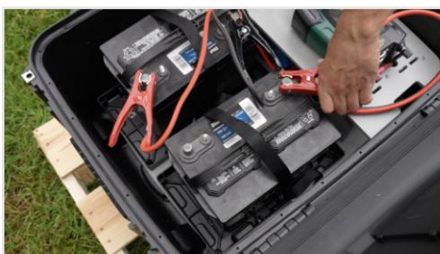
3) Placez les deux batteries à décharge profonde à l'intérieur du boîtier et fixez-les à l'aide de sangles. Fixez les câbles d'alimentation aux batteries, en veillant à ce que les câbles rouges soient liés aux bornes positives et les câbles noirs aux bornes négatives.
